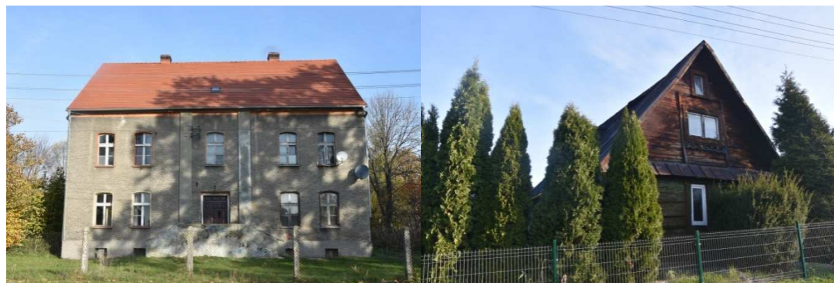
Fot. 6. Nędza, ul. Jesionowa 11, dawny dom celny; ul. Mickiewicza 55, dom mieszkalny (fot. autor).
